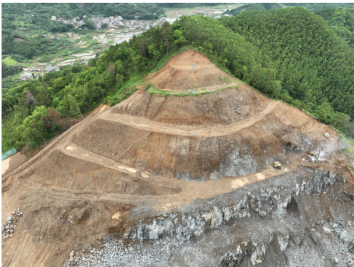
开采区南面上部终了边坡现状
